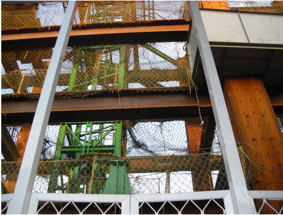
圖 3-35:防護網之確實設置-2 (蘇國樑/提供)
