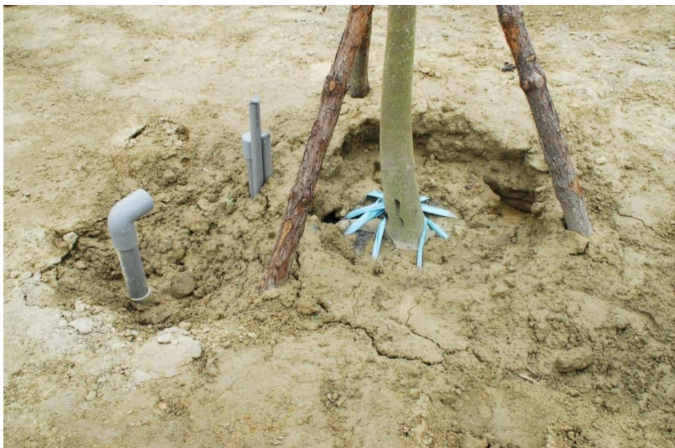
圖 5-13 小葉欖仁種植位置與噴灌系統太接近，將來恐樹根會破壞噴灌系統。另捆綁土團的塑膠繩未移除 (蔡智賢/提供)
