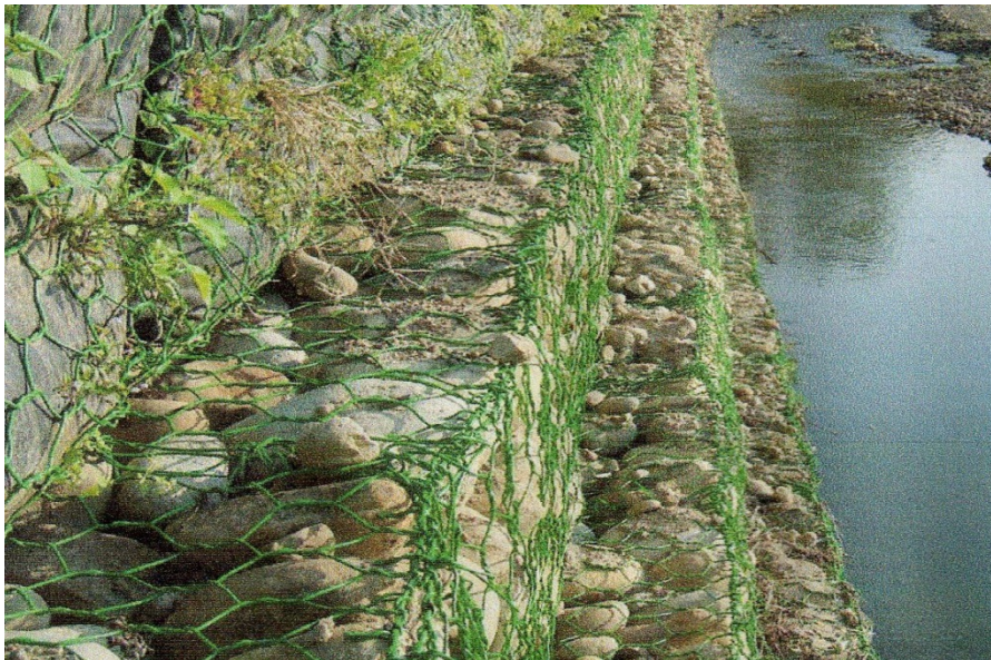
圖 1-9 石籠最外層之石料尺寸小於鉛絲籠口，該較小石塊易自籠口穿過流失（參考文獻 3）
