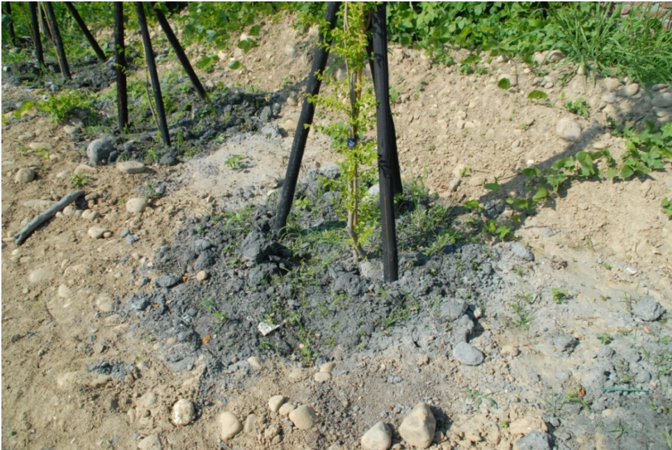
圖 5-15 未依設計圖施作，移除植穴周邊直徑大於 3 公分的礫石 (蔡智賢/提供)
