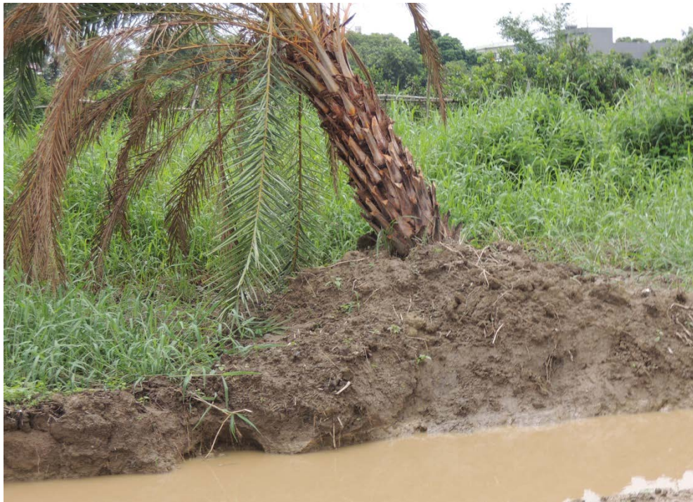
圖 5-17 未依植栽施工計畫及設計圖說施作，將臺灣海棗直立種植 (環保署/提供)
