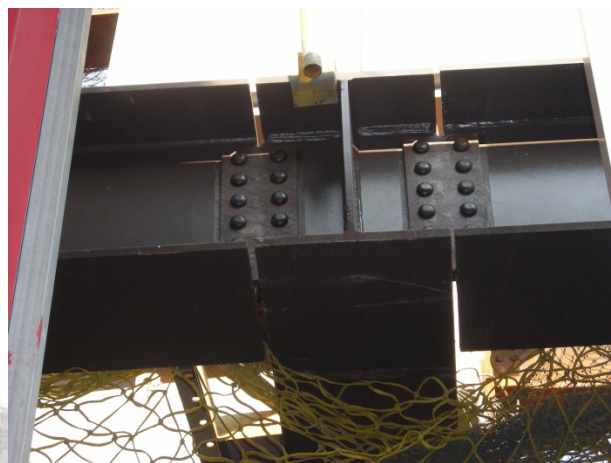
圖 3-23:高強度螺栓取樣送試驗室予以檢測 (蘇國樑/提供)
