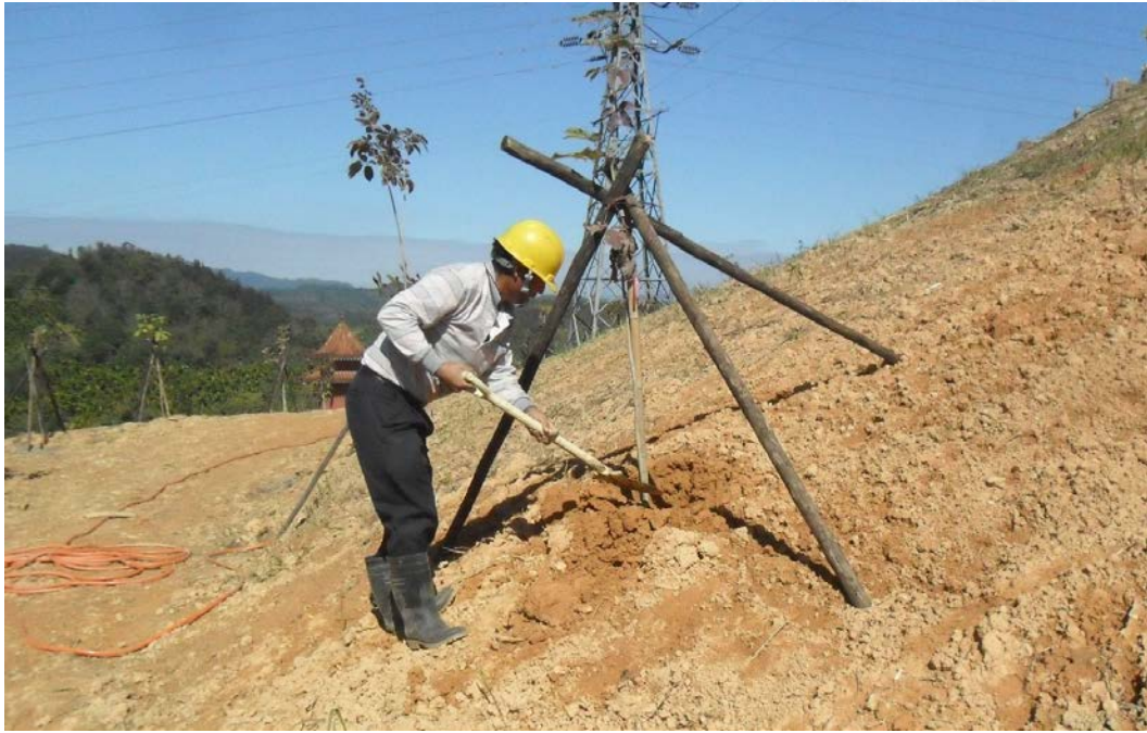
圖 5-29 邊坡植穴應設置凹槽 (環保署/提供)
