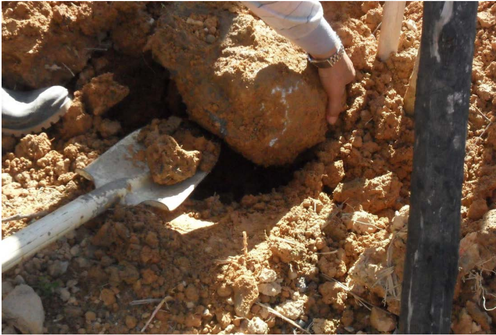
圖 5-14 未依設計圖施作，移除植穴內直徑大於 3 公分的礫石 (環保署/提供)
