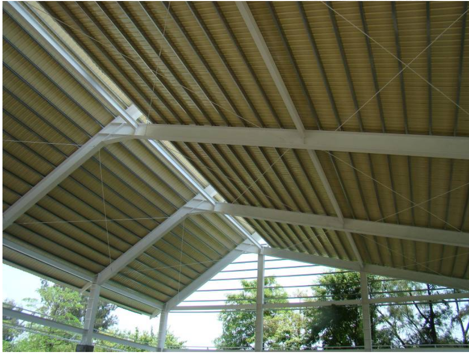
圖 3-18:此構造物無法抵抗側向力，例如:地震 (蘇國樑/提供)
