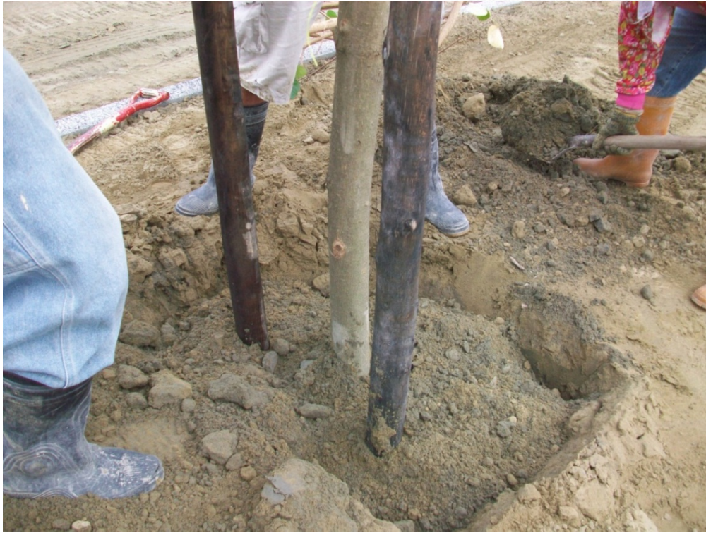
圖 5-12 依設計圖進行放樣，將種植的位置標示於現場，經負責監督工程施工的人員查核無誤後，進行開挖植穴與種植 (王崇安/提供)
