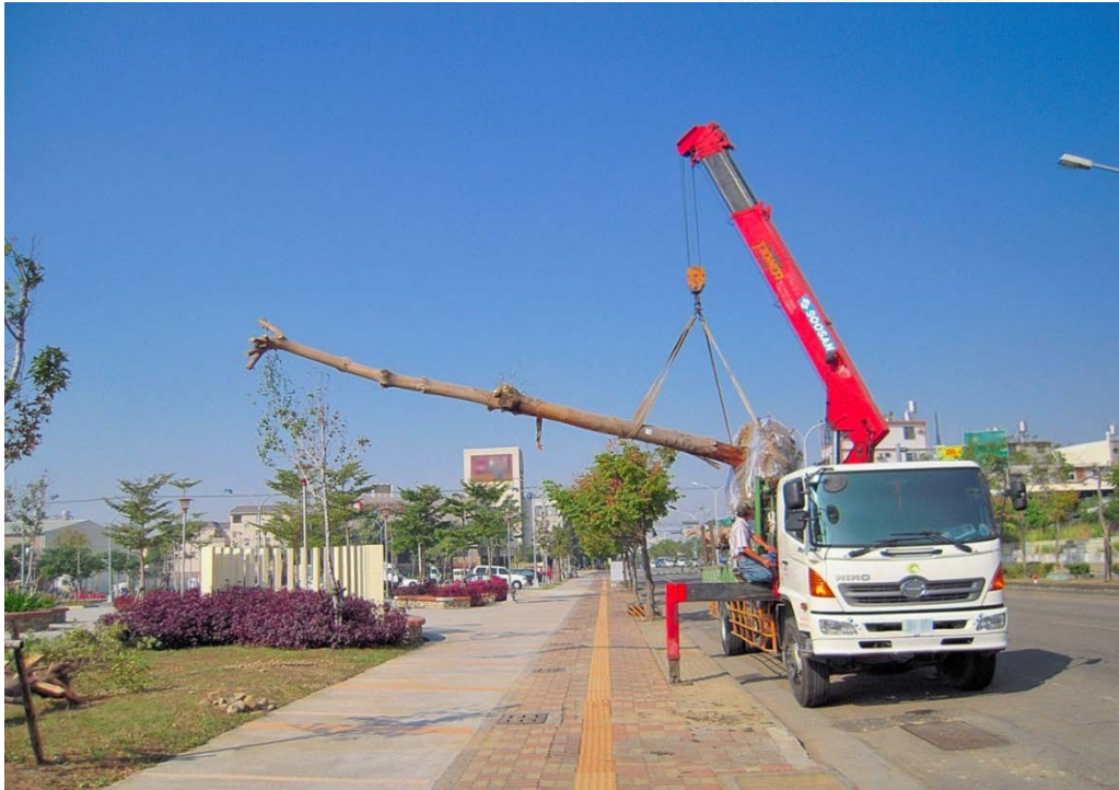
圖 5-25 喬木吊運前，主莖應以較厚的軟性物質包裹、保護，以免搬運中受損（蔡智賢/提供）
