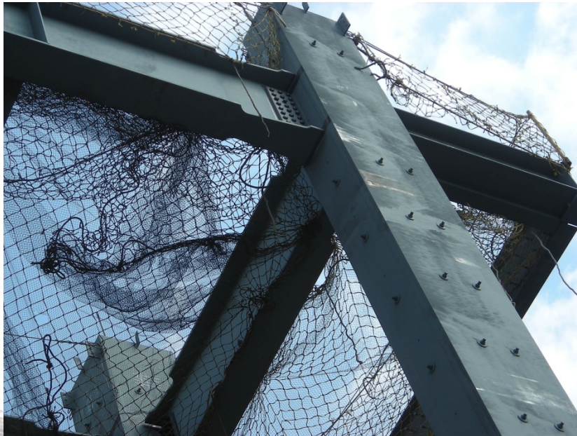
圖 3-34:防護網之確實設置-1 (蘇國樑/提供)
