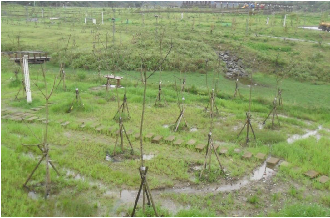
圖 5-5 不合格植栽。植栽未含有適量的葉片，無法判斷樹種，易造成驗收的困難度。裸根苗應預留較多的葉片（環保署/提供）
