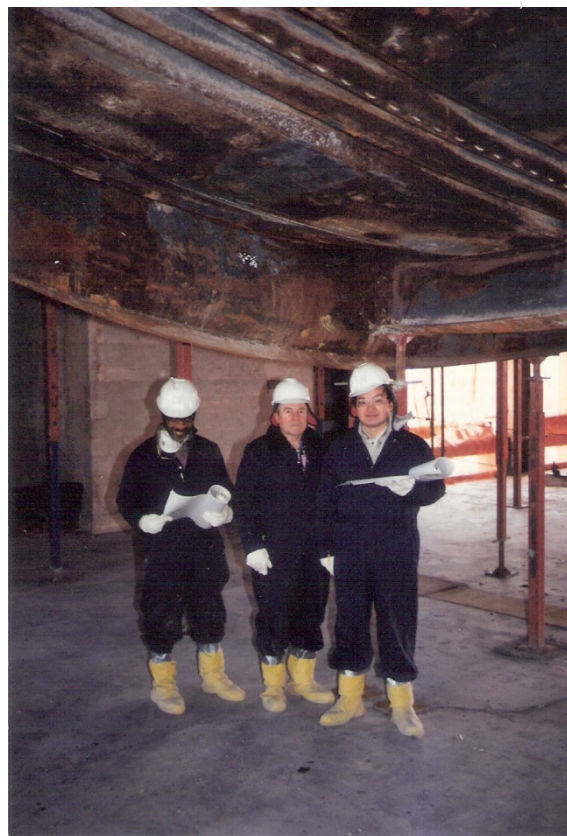
圖 3-6:高強度及高韌性，9 公尺之鋼樑因火災而中央下陷 1 公尺仍未破壞 (蘇國樑/提供)
