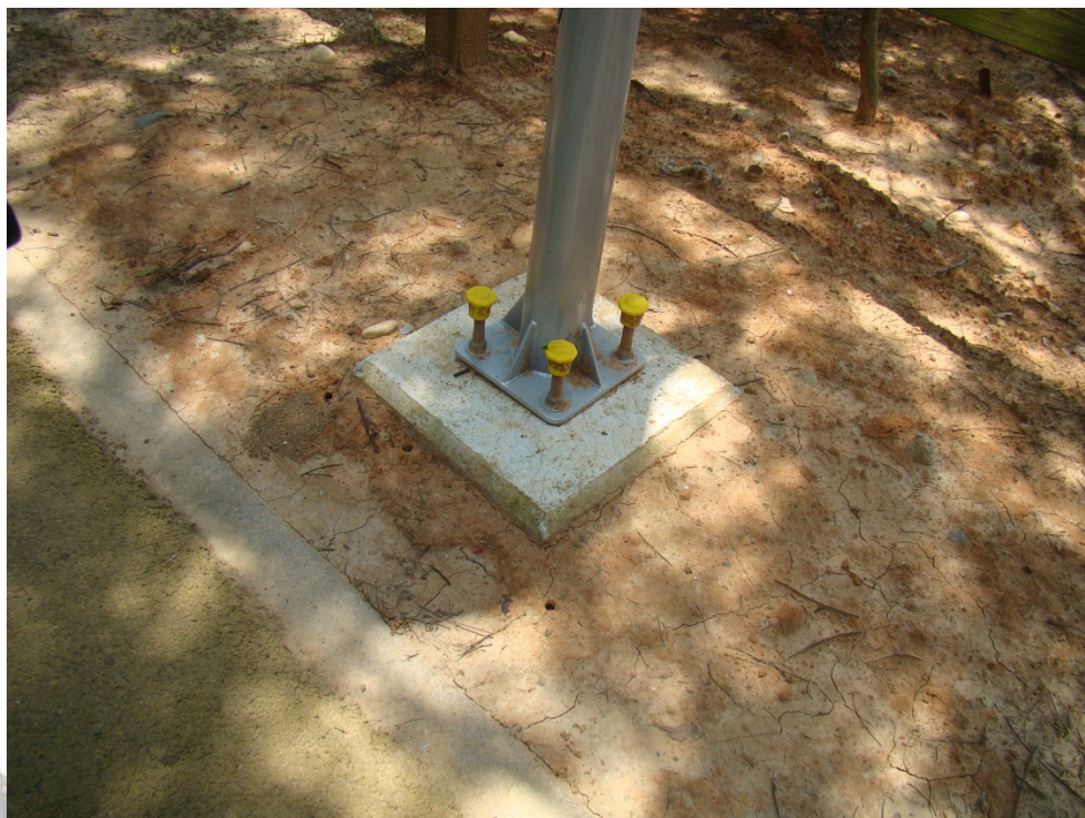
圖 3-28:預埋螺栓過長，必須予以暫時防護 (蘇國樑/提供)
