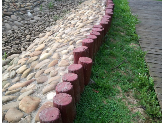
圖 1-13 木製護欄線形不平順美觀 (廖萬里/提供)
