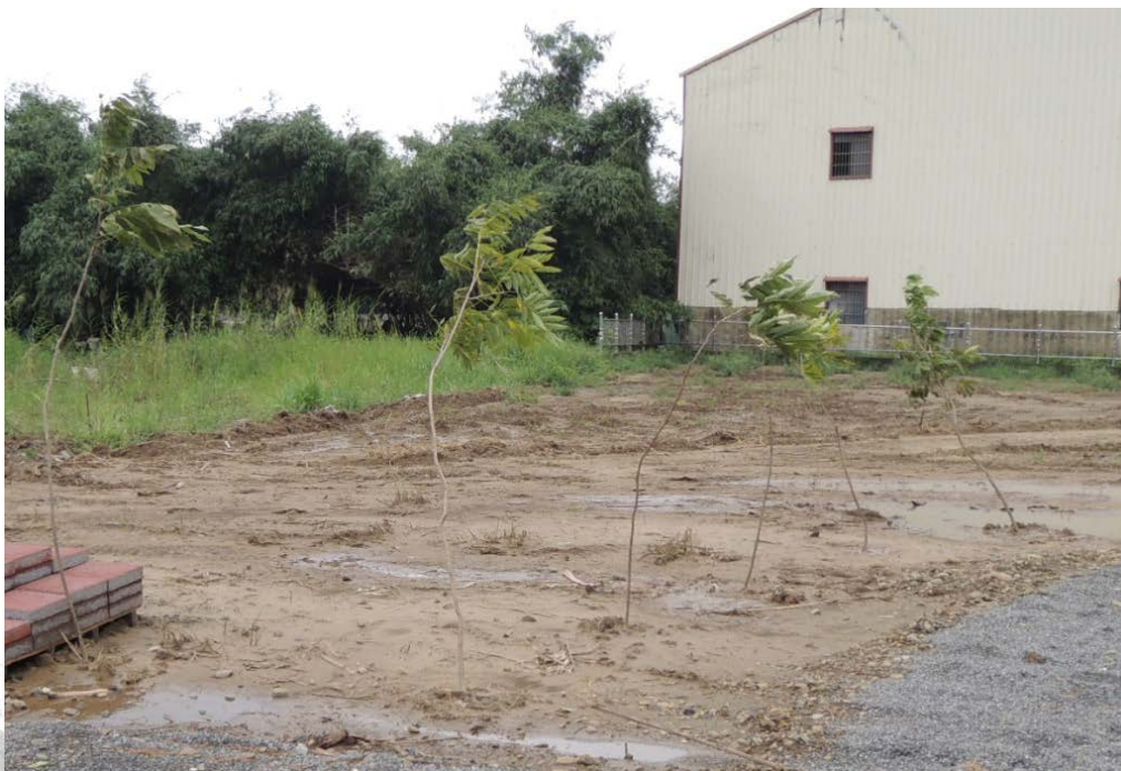
圖 5-2 莖纖細彎曲為不合格植栽。進場苗木查驗不確實，不合格苗應運離基地，以避免被誤用（環保署/提供）
