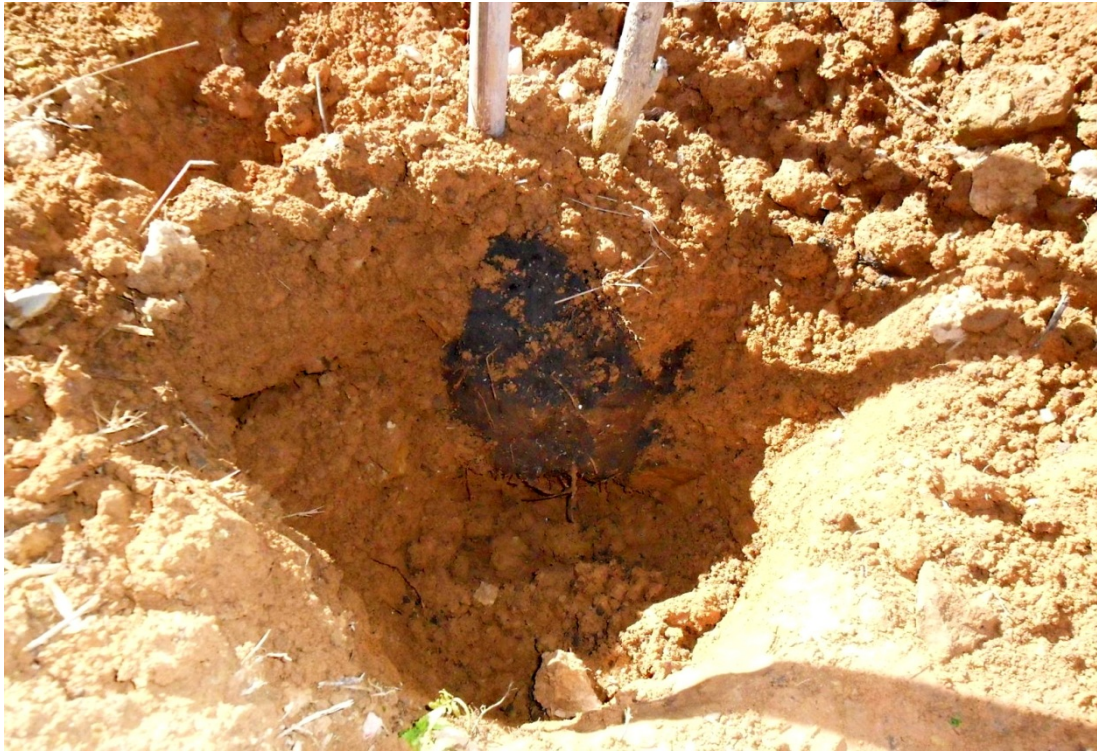
圖 5-27 土球下方未依設計圖施用有機質肥料 3 kg (蔡智賢/提供)
