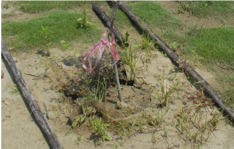
圖 5-16 未依設計圖施作，移除植穴內的美植袋容器 (蔡智賢/提供)
