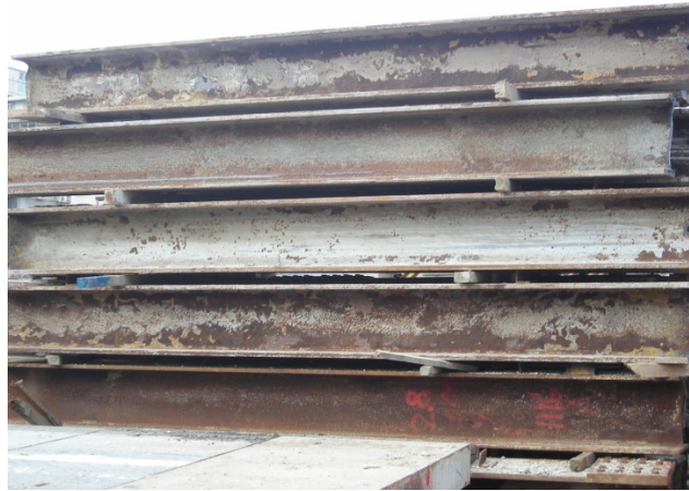
圖 3-22:鋼骨桿件取樣送試驗室予以檢測 (蘇國樑/提供)
