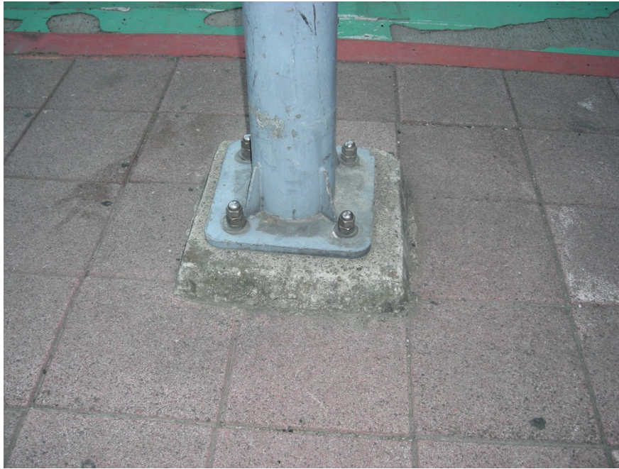
圖 3-33:柱底板應高於地面接觸，不易受損 (蘇國樑/提供)
