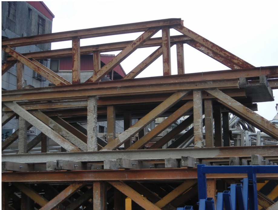
圖 3-24: 鋼骨結構之假安裝 (蘇國樑/提供)
