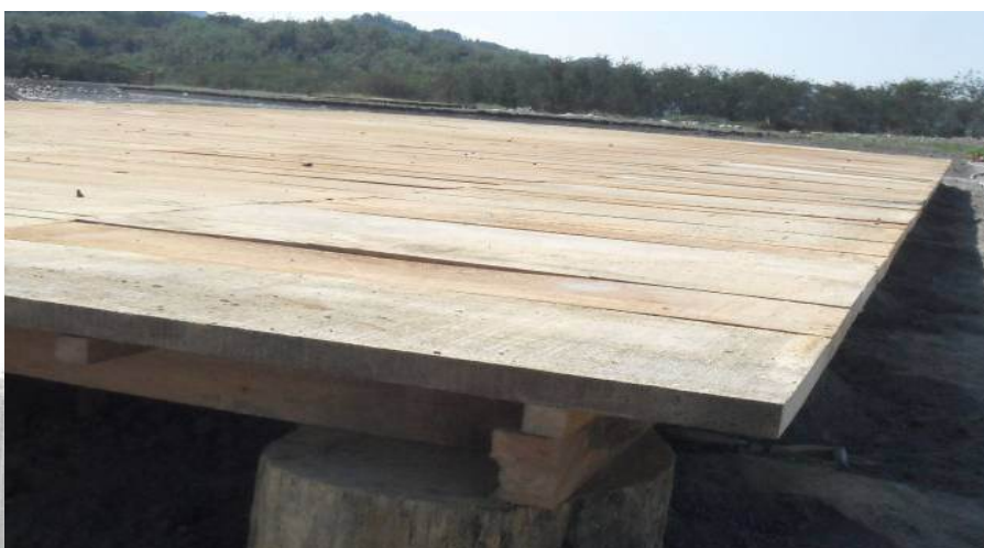
圖 1-11 木製鋪面鋪設之接縫不良且不平整 (環保署/提供)
