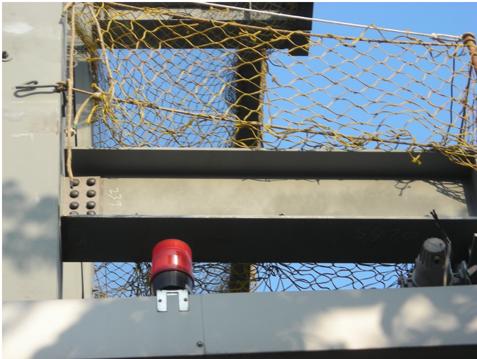
圖 3-36:防護網之確實設置-3 (蘇國樑/提供)
